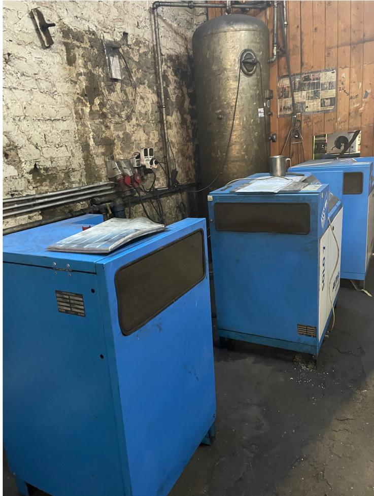
Aktuell sind zur Druckluftherzeugung 4 Schraubenkompressoren in Reihe geschaltet: 2 x 5,5 kW und 2 x 7,5 kW = 26 kW
