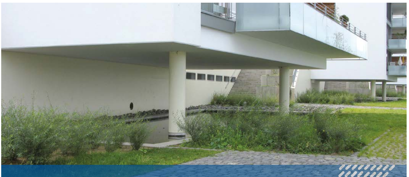
Abb. 24 Aufständerung eines Gebäudes
