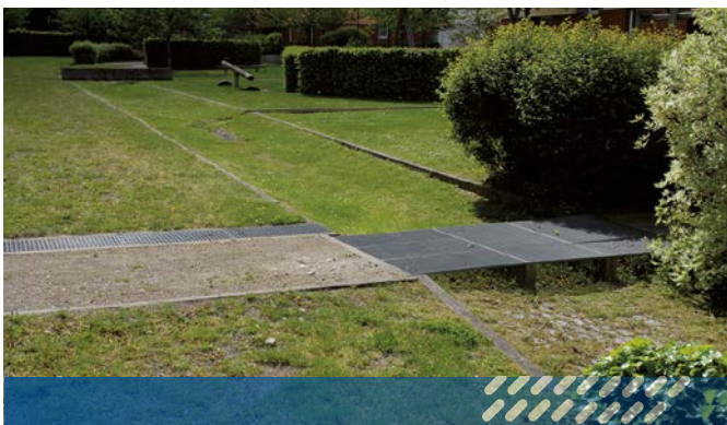
Abb. 10 b Abfluss über einen Notwasserweg
