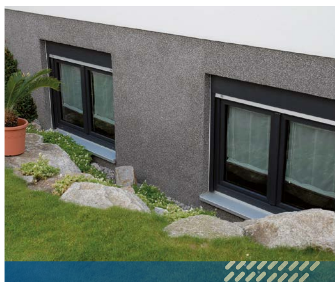
Abb. 17 Kellerfenster mit Sockel
